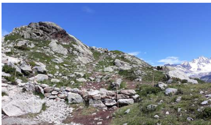
Installation provisoire pour éviter la création de nouvelles sentes (Crédit : CEN74)
