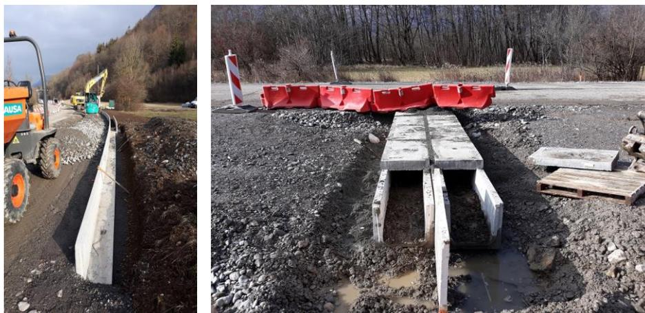
Figure 1 : Caniveau canalisant les amphibiens et la petite faune, et tunnels d'entrée et de sortie (photos 2019)
