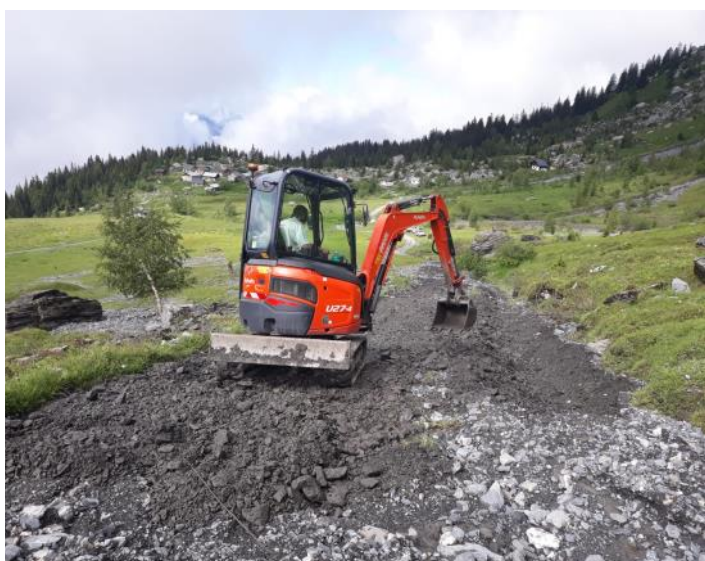
Crues torrentiels des nants du secteur des Ayères
