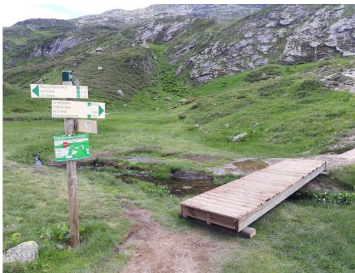
Passerelle de Pormenaz
