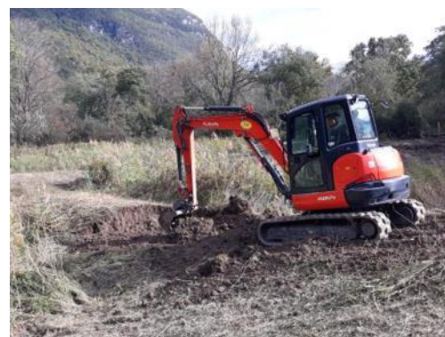
Travaux de restauration de la mare
