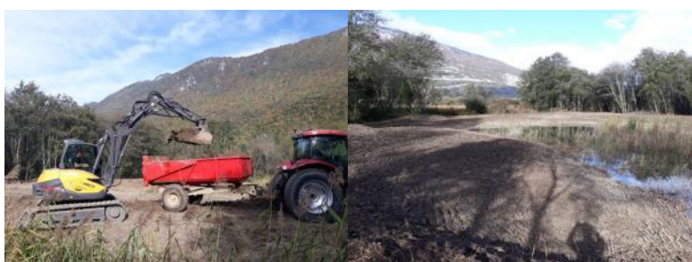
Travaux de restauration de la mare en octobre 2021
