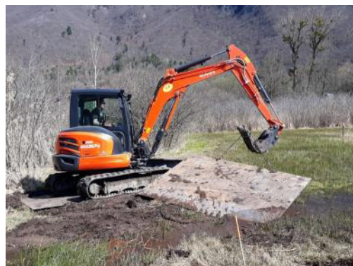
Travaux sur plaque dans le secteur Pré Poisson
