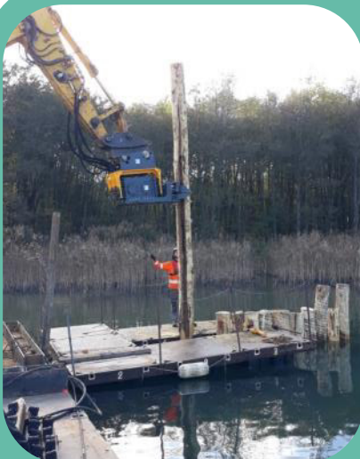
Pose des pieux en novembre 2021
