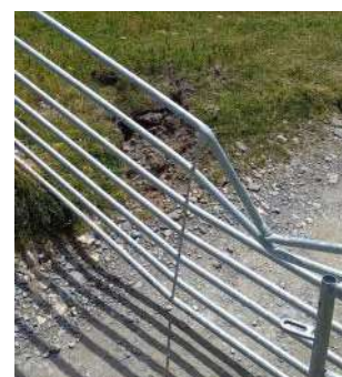
Chute de blocs et dégradation des équipements pastoraux Crédit : CEN74
