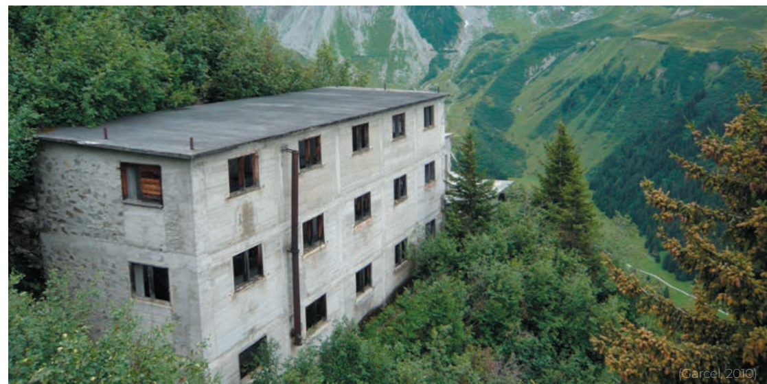
Cantine F4 avant démolition - 2010.
