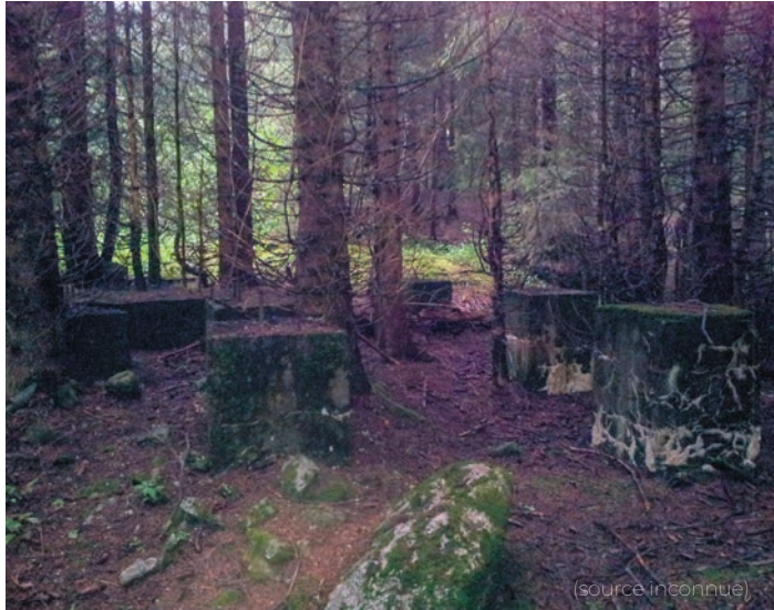
Piliers téléphérique Combe Noire.
