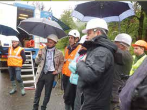
Neutrelisation d'une ligne électrique à Sixt-Fer-à-Cheval
