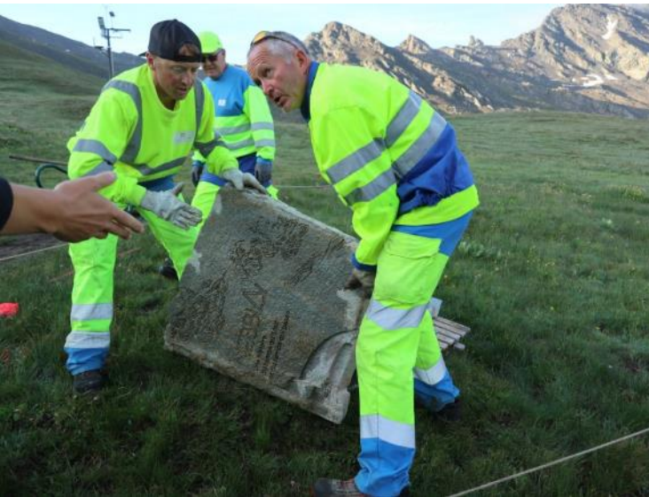
Positionnement des dalles de pierre par le Service Routes
